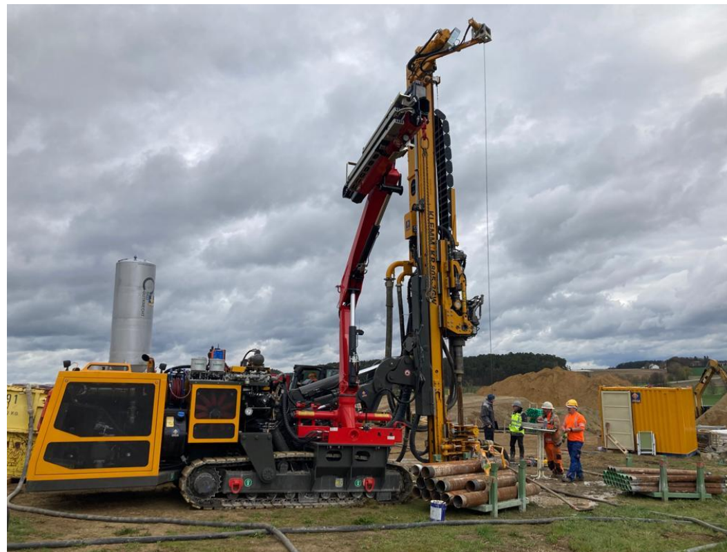
Aufbau zur Erstellung eines Bohrlochs
