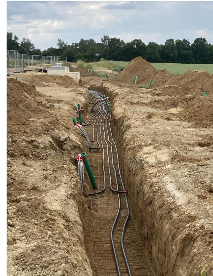
Sondenführung horizontal
