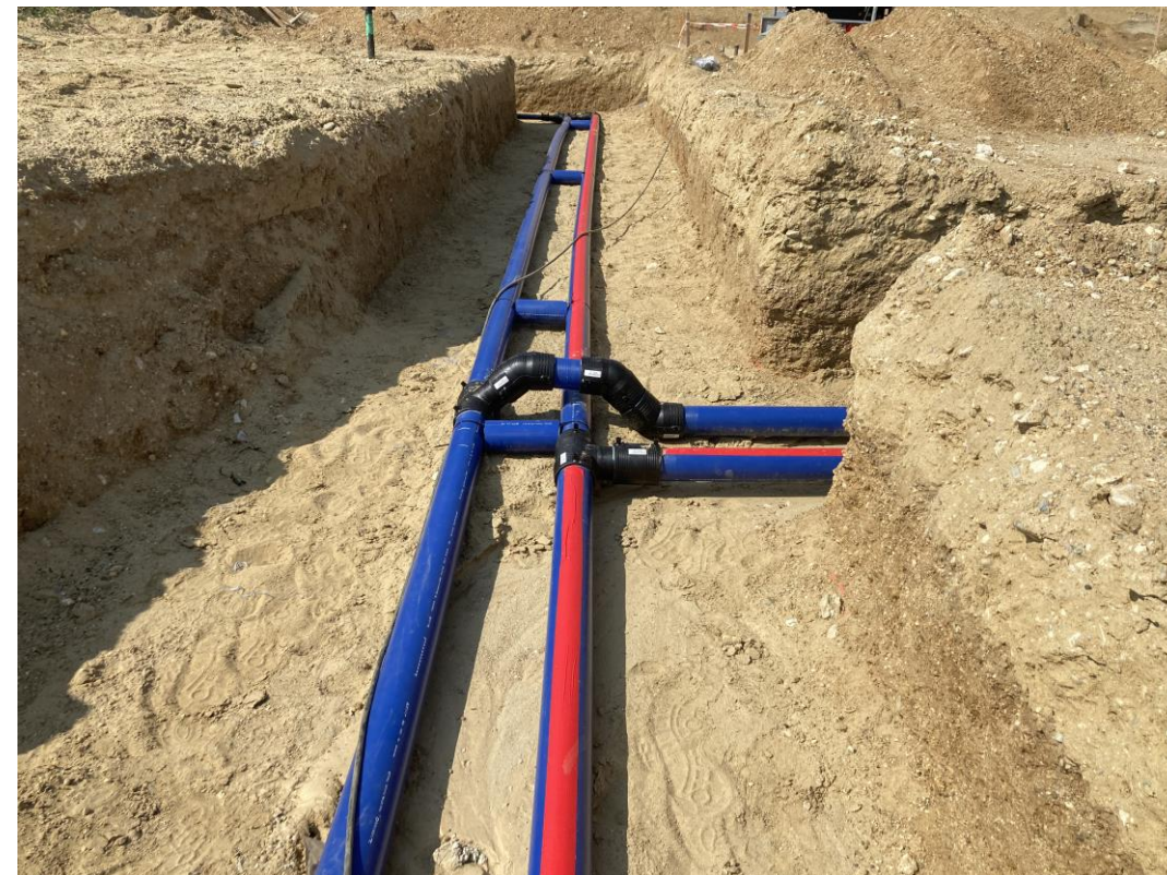
Hauptleitung im Graben
