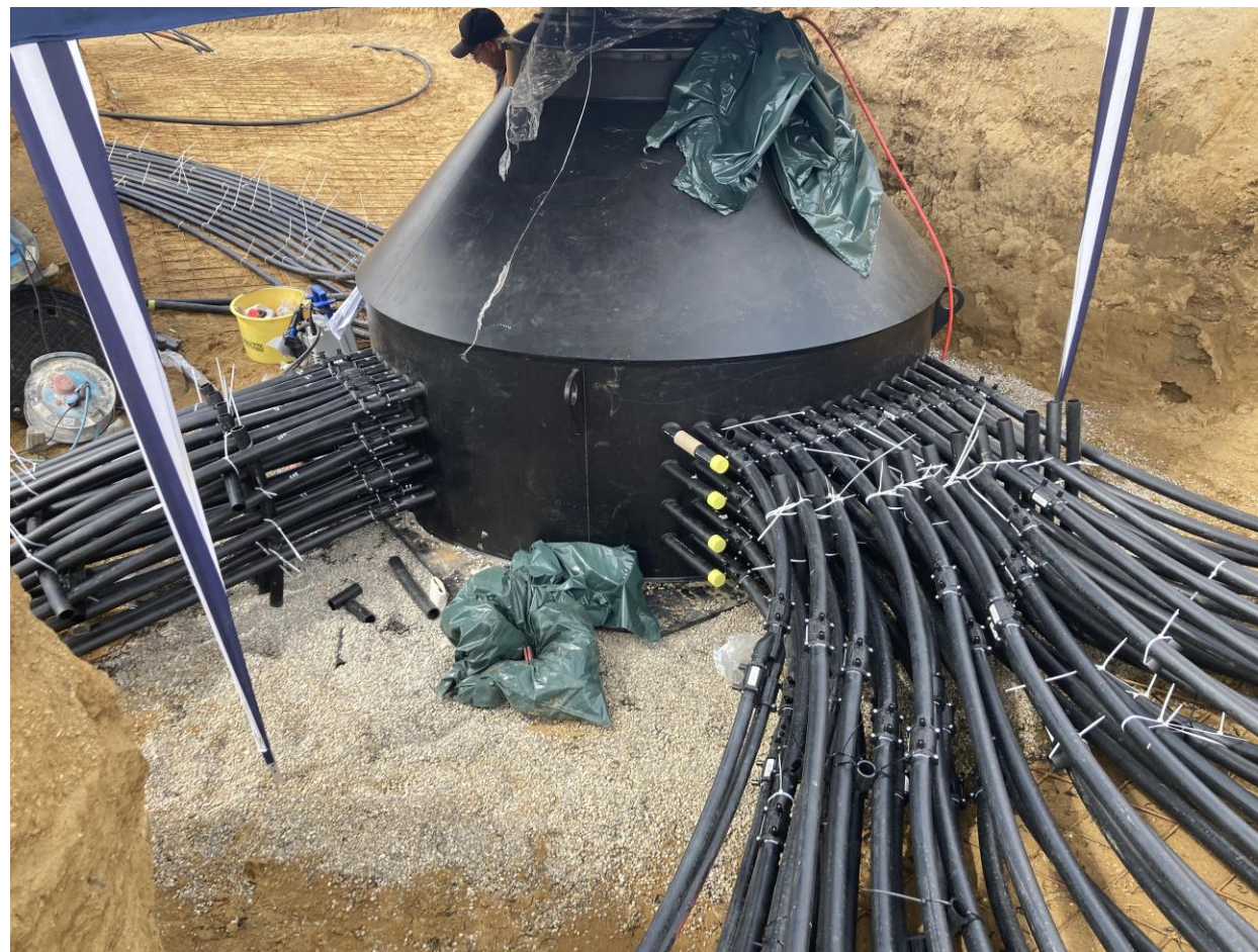
Verteilerschacht
