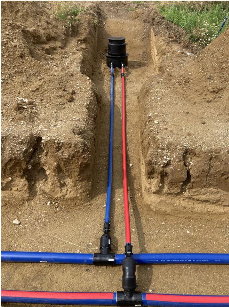
Stichleitung Netz an Grundstück
